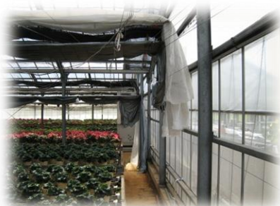
妻面のカーテンの隙間
