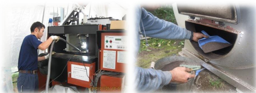
木質バイオマス利用加温設備の燃焼灰の清掃
