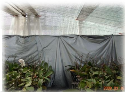
温室北面へ断熱資材を固定張り
