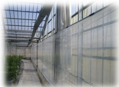
妻面のカーテンの隙間対策①
