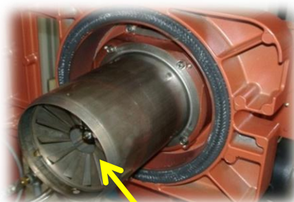
清掃後のエアコーン、ディフューザーの状態
