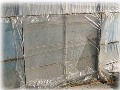
使用しない出入口を目張り
