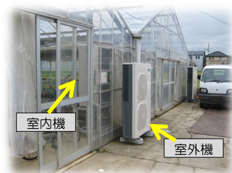
室内機と室外機の適切な設置例
