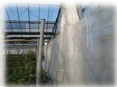
妻面のカーテンの隙間対策②
