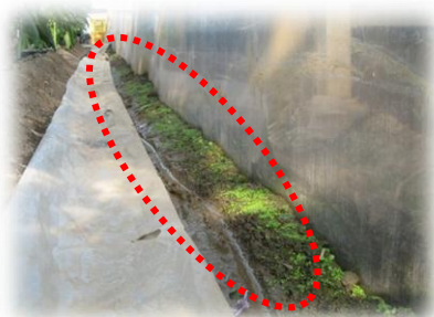
カーテン裾部の固定（土盛り）
