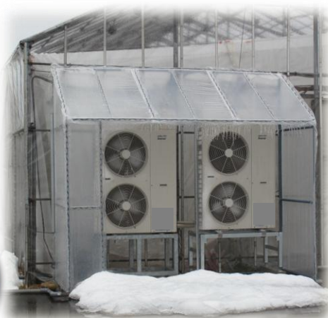
デフロスト水、積雪に対応した適切な設置例
