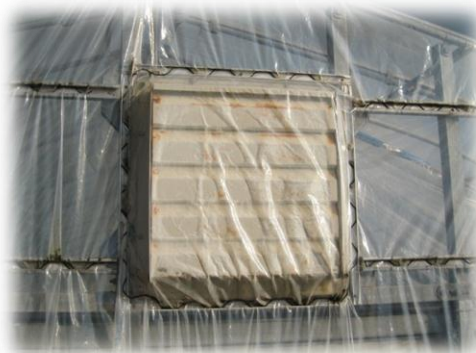
換気扇シャッターを目張り
