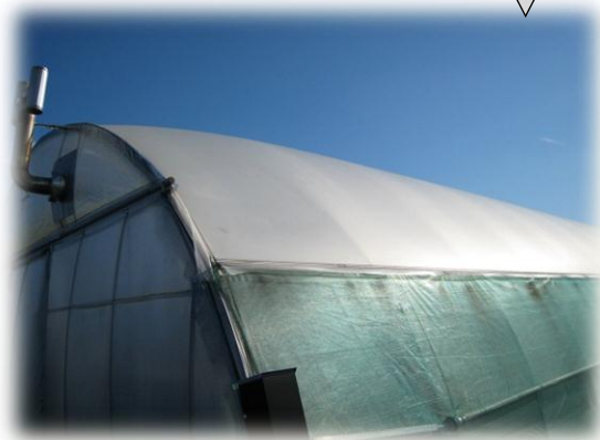
空気膜2重被覆（屋根部）
