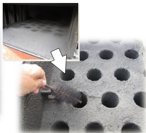
木質バイオマス利用加温設備の燃焼灰の清掃
