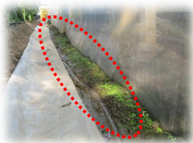
カーテン裾部の固定（土盛り）
