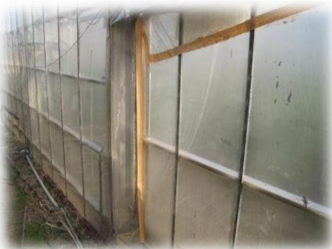
外張被覆の隙間を目張り
