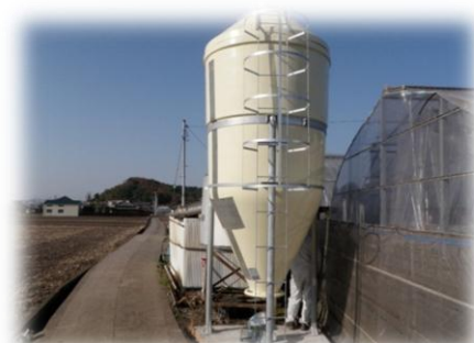
6.4m 3 の貯蔵タンク（高さ5m）
