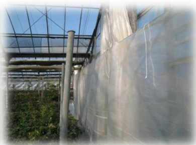
妻面のカーテンの隙間対策②
