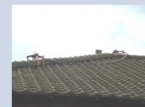
畜舎屋根へのスプリンクラー設置
