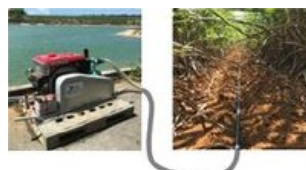
遠隔操作によるかん水ポンプの起動
