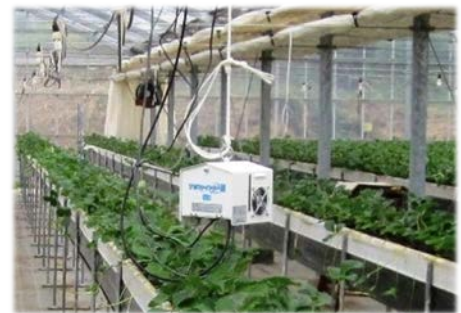
設置した環境測定装置
