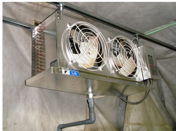
写真3 既存貯蔵庫に追加した冷却装置
