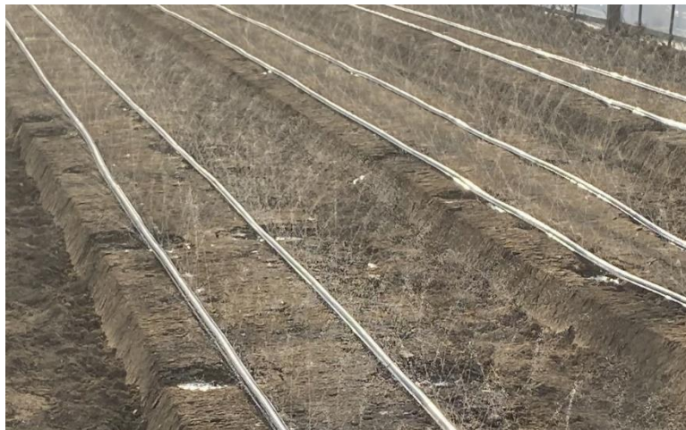
図Ⅲ - 2 破損したかん水チューブによる畝の崩壊及び陥没
