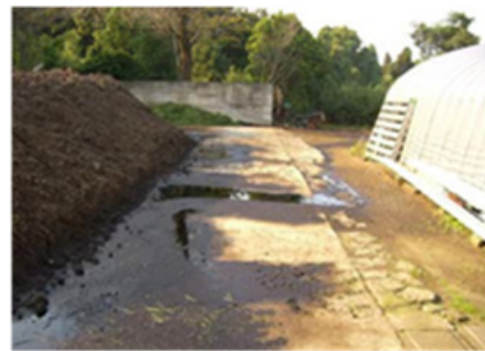
図3 堆肥の廃汁流出（提供：富山県）
