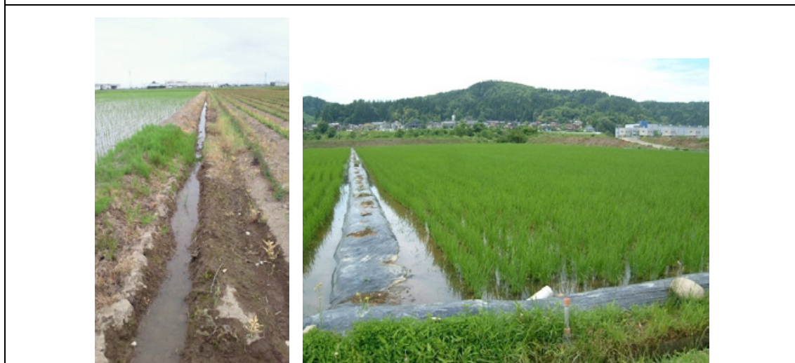
図2 除草剤の多用による畦畔崩壊
