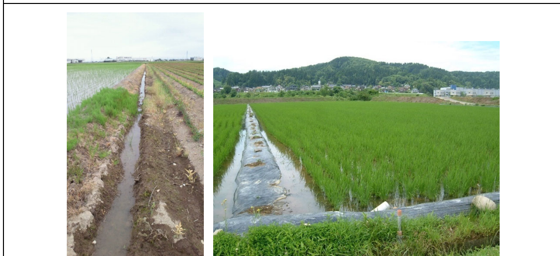
図 2 除草剤の多用による畦畔崩壊
