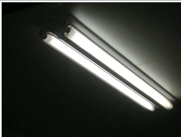
図3 蛍光灯カバーによる飛散防止
