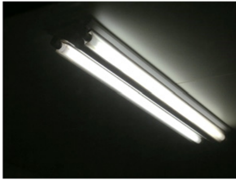
図3 蛍光灯カバーによる飛散防止
