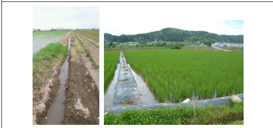
図2 除草剤の多用による畦畔崩壊
