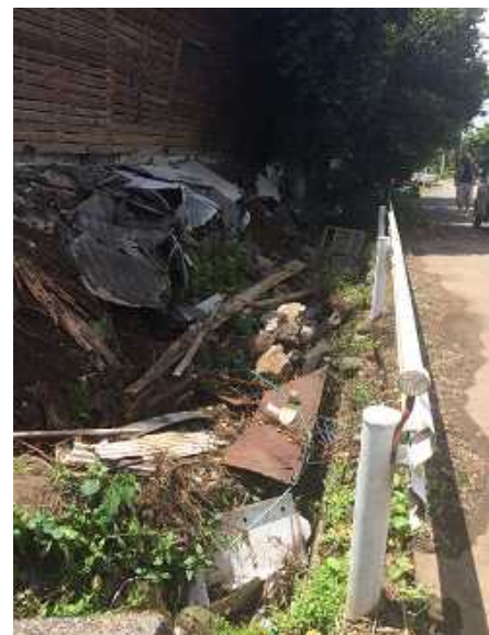
納屋の倒壊による水路の塞ぎ
