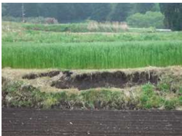
二条大麦ほ場の法面の損壊（大津町）
