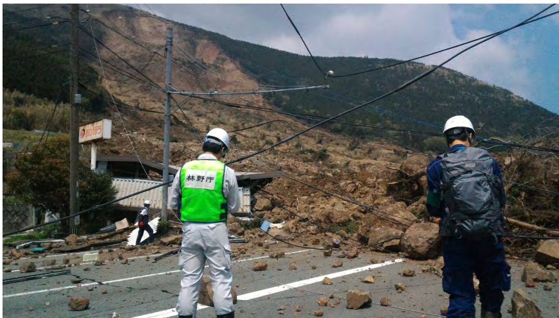
国道57号線から崩壊地上部の状況
