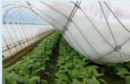
・積雪により倒壊したハウス内
