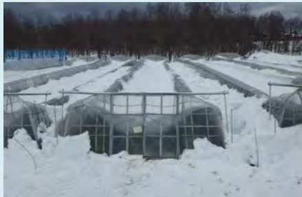
・積雪により倒壊したハウス
