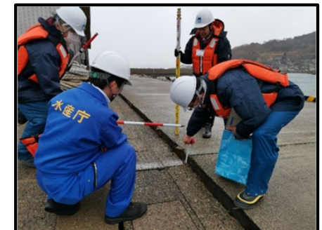
【漁港被害調査】
