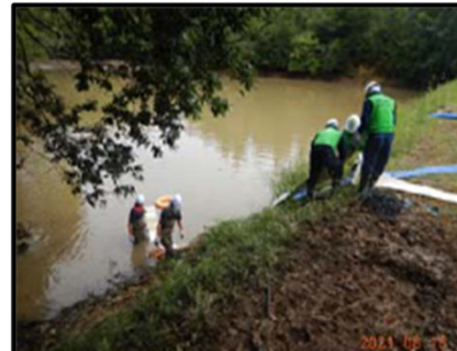
【排水ポンプによる技術支援】
