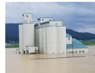
浸水した共同利用施設
