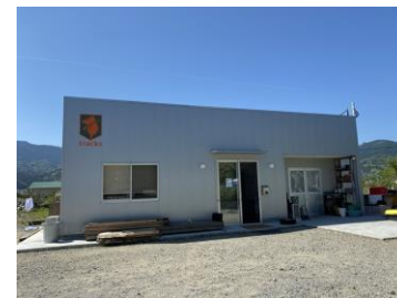
<処理施設の外観>
