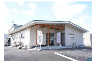
<処理施設の外観>
