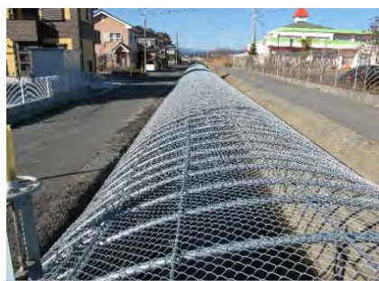
② アーチ型ネットフェンス
