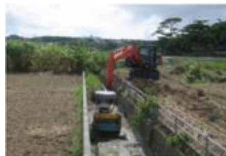
水路の土砂上げ作業
