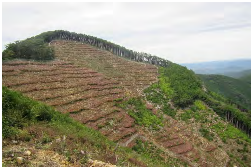
植栽完了現場写真
