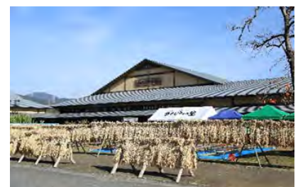
みなみの里全景
