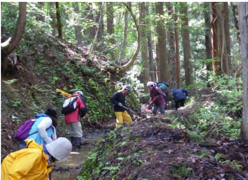
ボランティアによる堰浚いの様子
