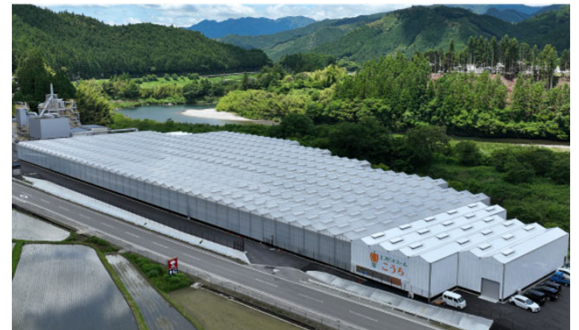
木質バイオマス発電所と次世代型園芸施設
