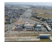
排水機場の整備
