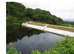
老朽化したため池の 全面改修
