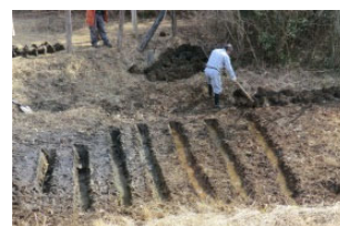
土砂堆積部分の浚渫
