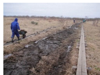
水抜き水路の埋め戻し
