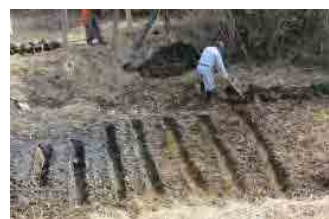
土砂堆積部分の浚渫
