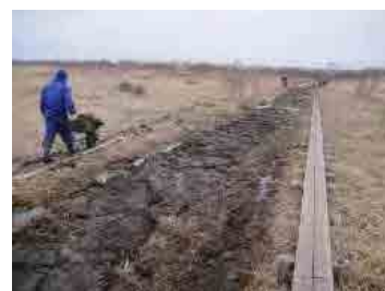
水抜き水路の埋め戻し
