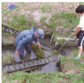
①水路と水田を結ぶ水田魚道
