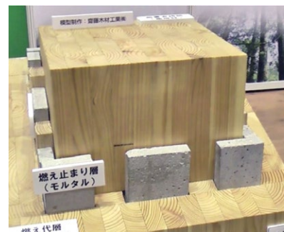
燃え止まり層 (モルタル) 断面 (mm) : 472×472
