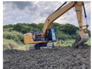
パワーショベルによる天地返し。
