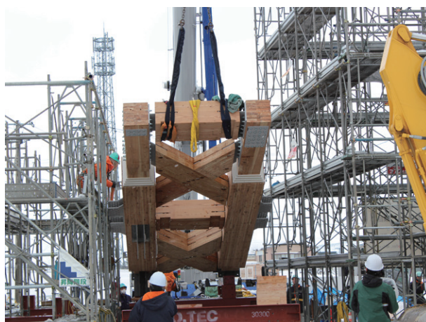
柱ユニットを組み立てる様子。
