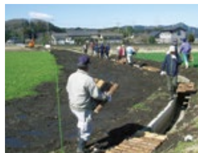
水路へのふたの設置作業。コンクリートの水路は、管理の負担を軽減する一方、カエルが落ちると壁を登れず溺れてしまう。
