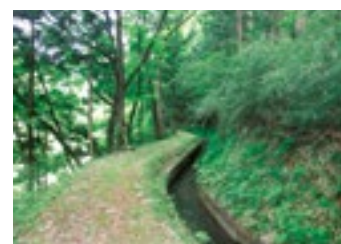
照井堰用水 (岩手県一関市、平泉町)
