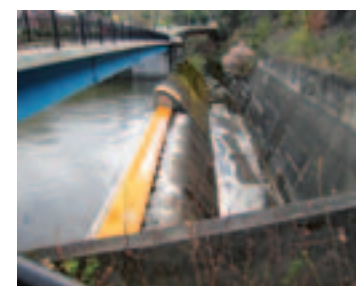
現在の入鹿池の余水吐(よすいばき・余分な水を放流する設備)。
