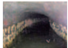
ノミだけで掘削した昔のトンネル。
