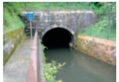
山を貫通する現在の水路トンネル。
