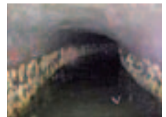
ノミだけで掘削した昔のトンネル。
