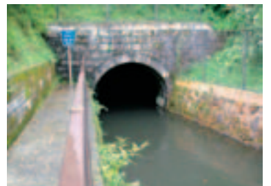
山を貫通する現在の水路トンネル。
