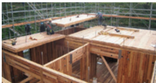
CLTパネルを使った建築物の施工の様子
