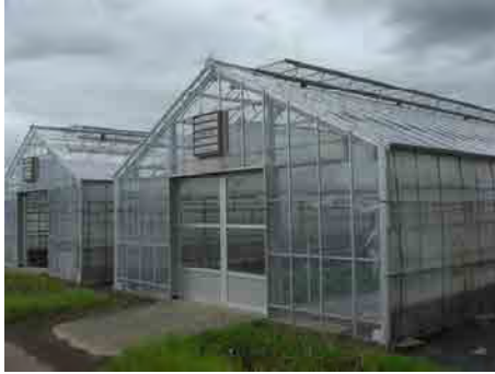
試験を実施した施設
