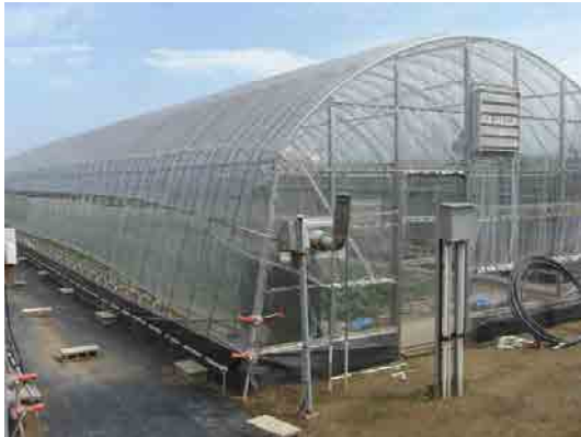
試験を実施した施設
