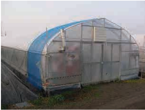
写真1. 試験施設外観
