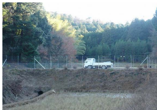
【獣害フェンスの設置】
