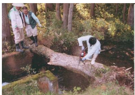
【先人から受け継いだ水路の災害復旧】
