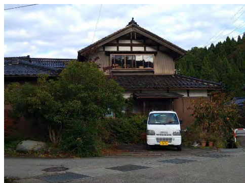
【空き家となった住宅】
