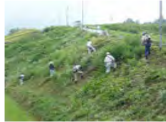
【道路法面の共同草刈り作業】
