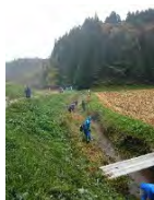
【水路の維持管理】
