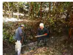
【定期的な泥上げ作業】
