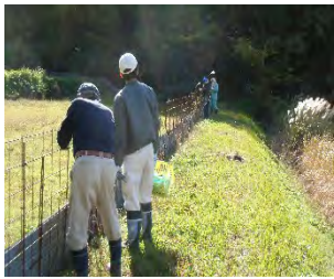
【ワイヤーメッシュ点検、補修】
