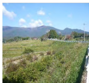
【道路及び圃場法面の急傾斜】
