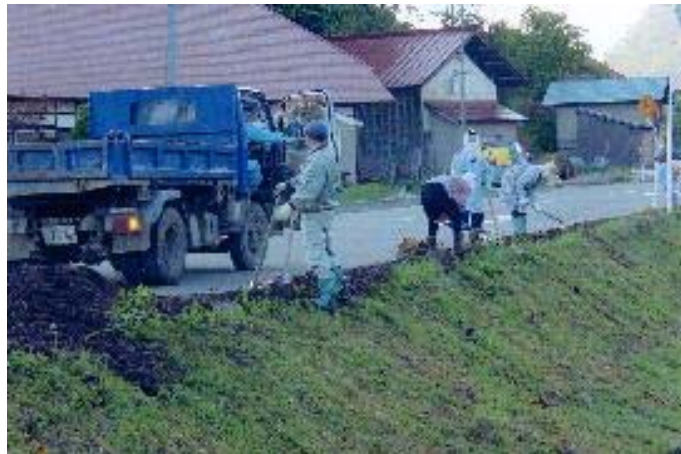
農道の簡易補修
