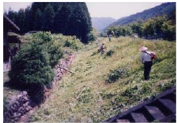
法面の草刈り
