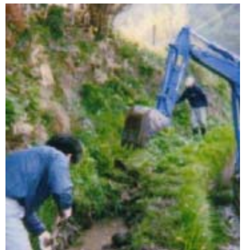
取得した重機免許で水路を整備
