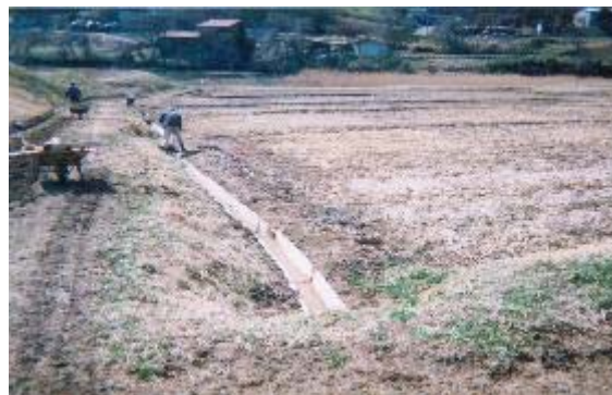
用水路の改修
