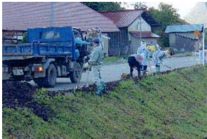
農道の簡易補修
