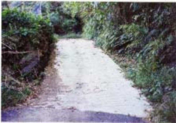
農地への取付道（舗装後）
