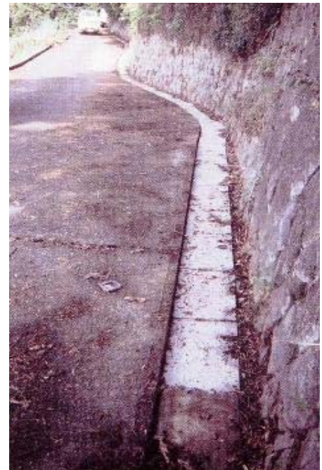
着手後 （見事に水路が確保された）
