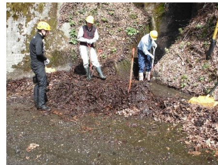
【水路補修の様子】
