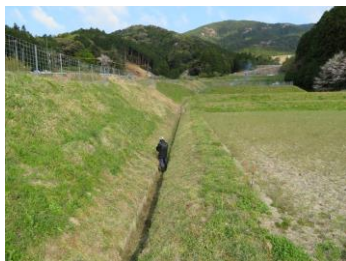
【片山地内の取組箇所】
