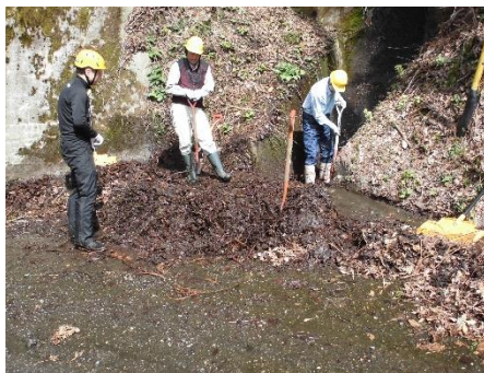
【水路補修の様子】
