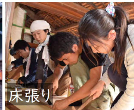
古民家の床張り事業
