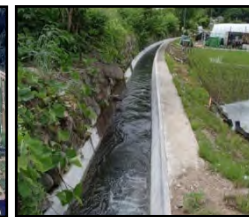
老朽化した用水路の整備・更新
