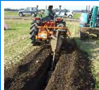
暗渠排水の整備
