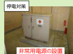
非常用電源の設置
