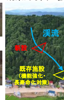
既存施設を有効活用した治山対策
