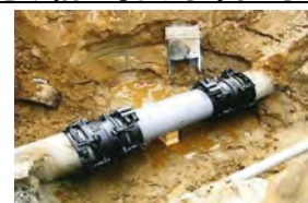
漏水防止のための整備
