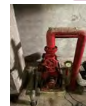
老朽化した消火ポンプの更新
