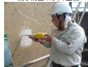
老朽化した施設の機能診断
