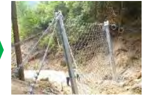
簡易な構造物による応急対策
