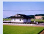
農業集落排水施設
